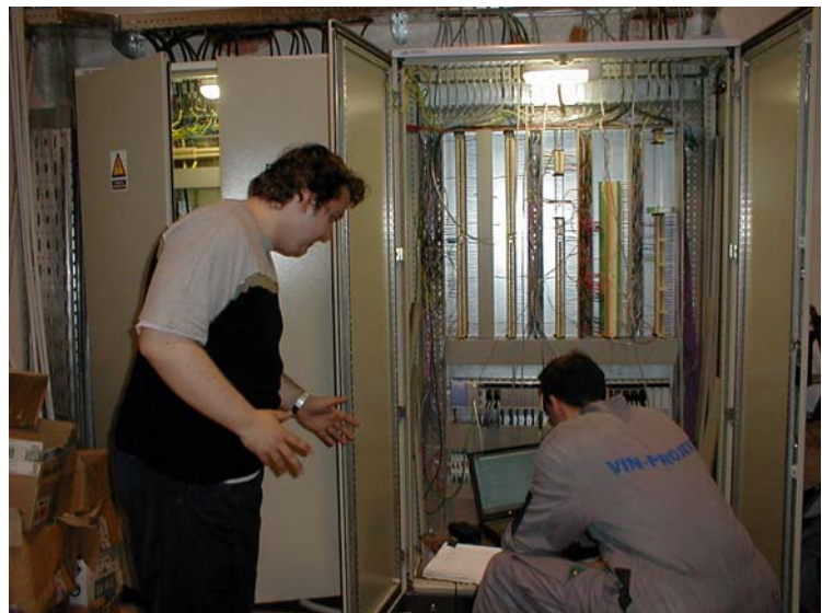
«PERUTNINA PTUJ-PIPO» d.o.o. – Čakovec Rekonstrukcija mješaone stočne hrane
